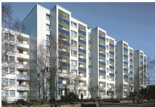
Abb.6: Gebäudeintegrierte Photovoltaik in der Solarsiedlung Köln-Bocklemünd, Sanierung einer 70er-Jahre Siedlung
