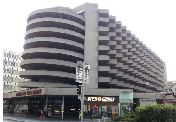
Abb. 1: Parkhaus Balestra Lugano (Foto: A. Ruch)
