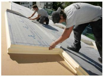
Fig. 7: Installation of PU rigid foam panels as above-rafter insulation. Source: Baustoffwissen, RM Handelsmedien GmbH & Co. KG: Dämmstoffe, Einsatzbereiche von PU-Hartschaum. URL:
